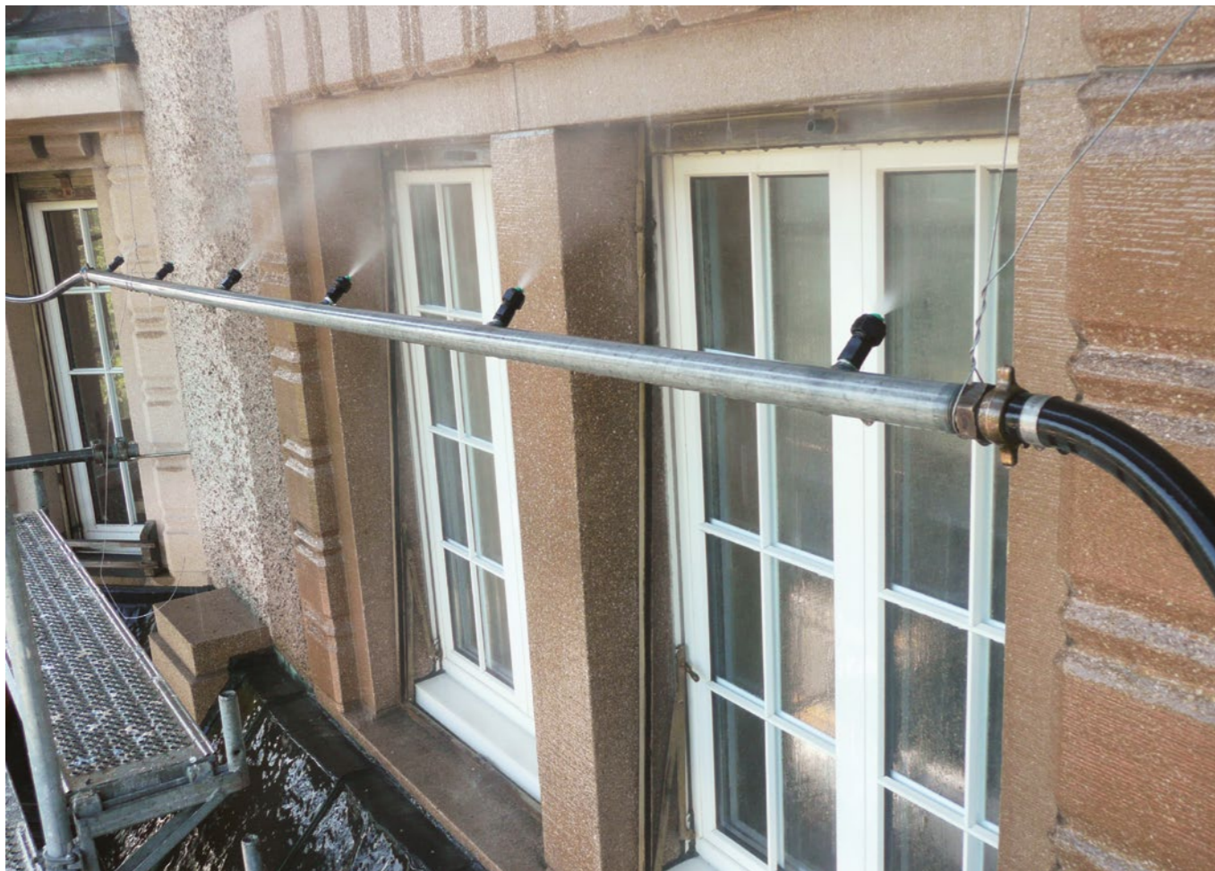
Spezialreinigung einer Natursteinfassade
