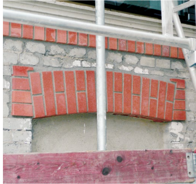
Ersatz eines Rundbogensturzes
