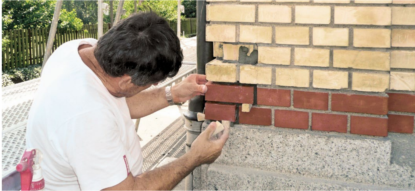
Sanierung einer Ecklisen
