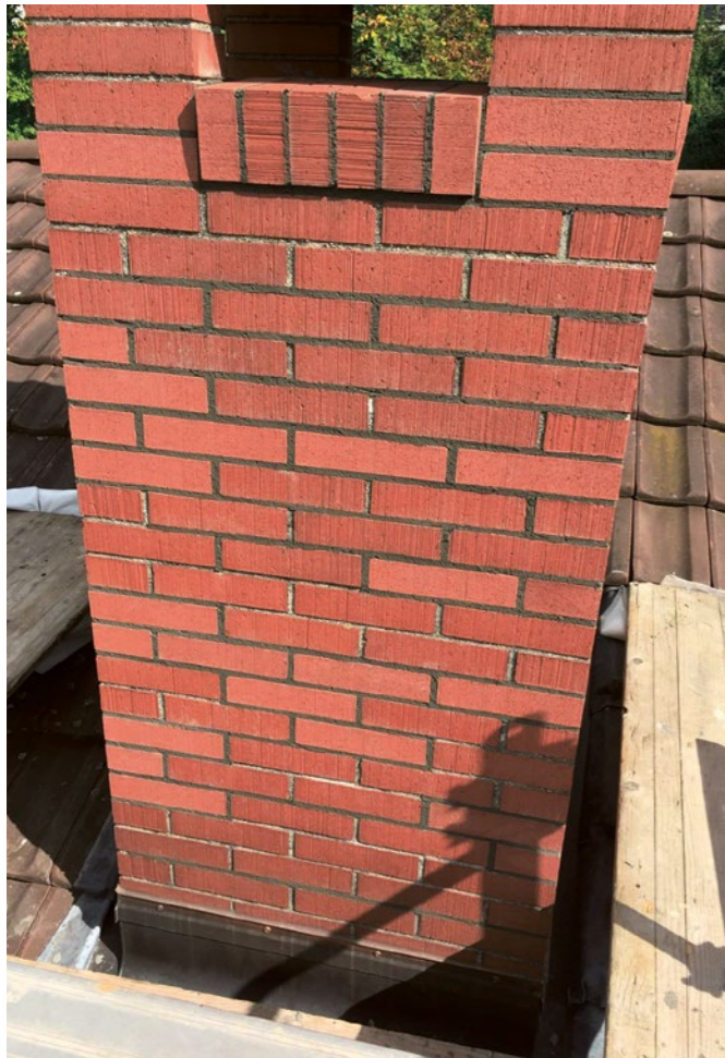
Neu eingesetzte Sichtsteinblender mit neuen Mörtelfugen
