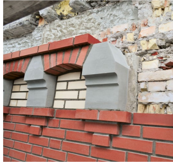
Originalgetreue Rekonstruktion der ursprünglichen Fassade, kombiniert mit Natursteinen
